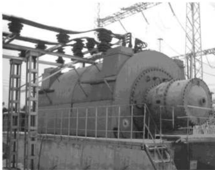
Рисунок 1.19 – Общий вид синхронного компенсатора с водородным охлаждением при открытой его установке на подстанции энергосистемы
