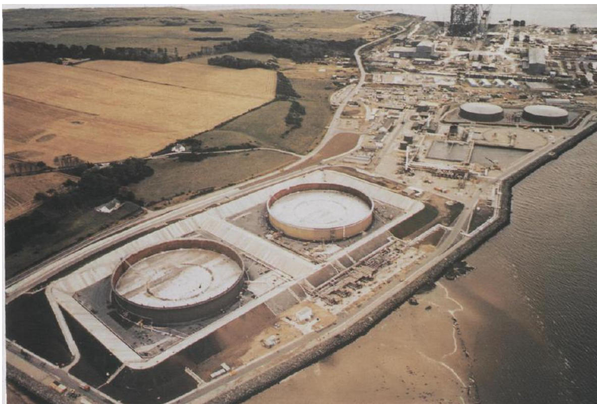
Рис. 1. Резервуары с плавающей крышей
