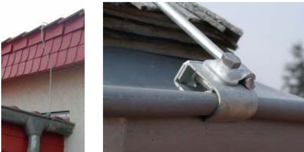
Рис. 29. Пример выполнения соединений металлического водосточного желоба с элементами молниезащитного устройства.
