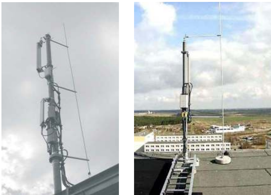
Рис. 23. Размещение антенных мачт в защищаемых вертикальными молниеприемниками пространствах
