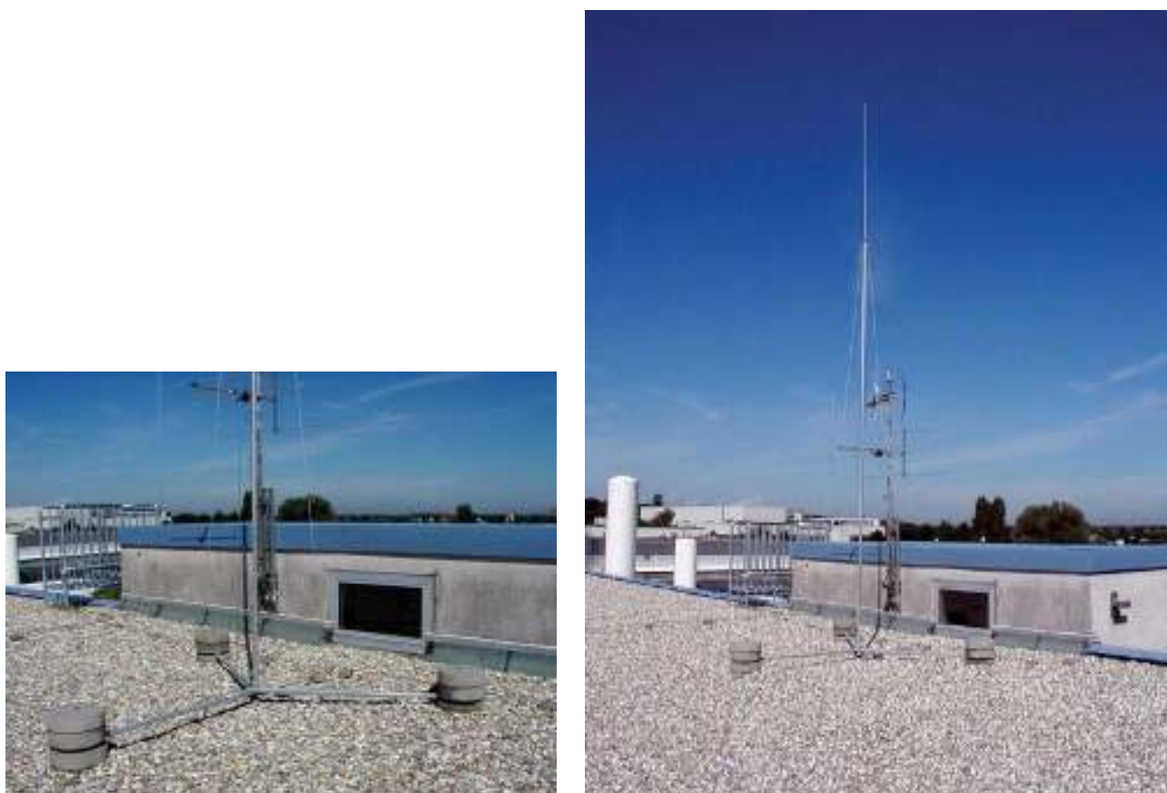
Рис.14 . Одиночные вертикальные молниеприемники [ ]
