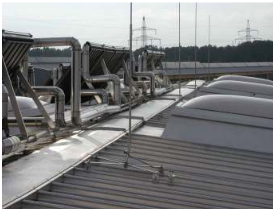
Рис. 12. Крепление приемников к проводящим элементам поверхности крыши
