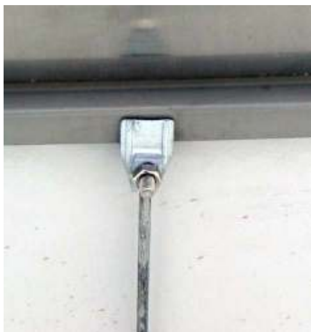
Рис. 31. Отведение тока молнии с металлического покрытия крыши
