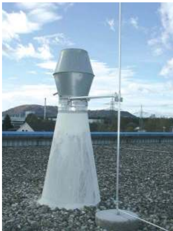
Рис. 16. Примеры молниеприемников, прикрепленных к защищаемым объектам [ ]
