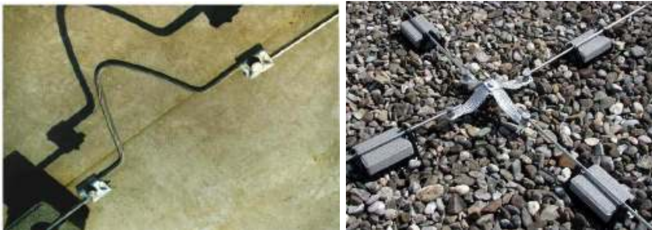
Рис. 6. Соединения, компенсирующие напряжения, возникающие при изменении температуры
