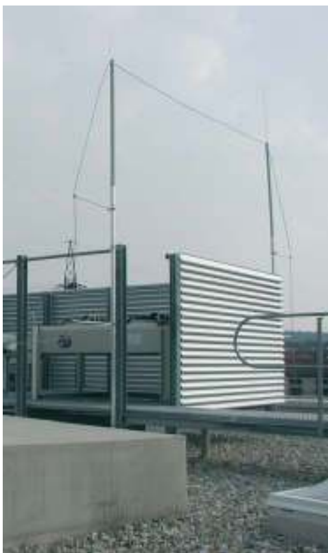
Рис. 16. Примеры молниеприемников, прикрепленных к защищаемым объектам [ ]
