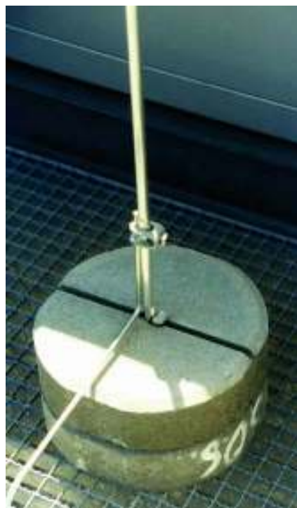
Рис. 11. Крепление молниеприемников различной высоты к бетонным опорам
