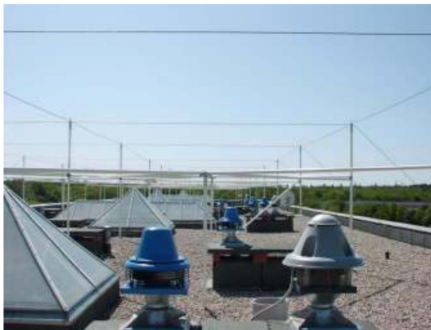
Рис. 27. Молниезащита устройств на крыше строительного объекта
