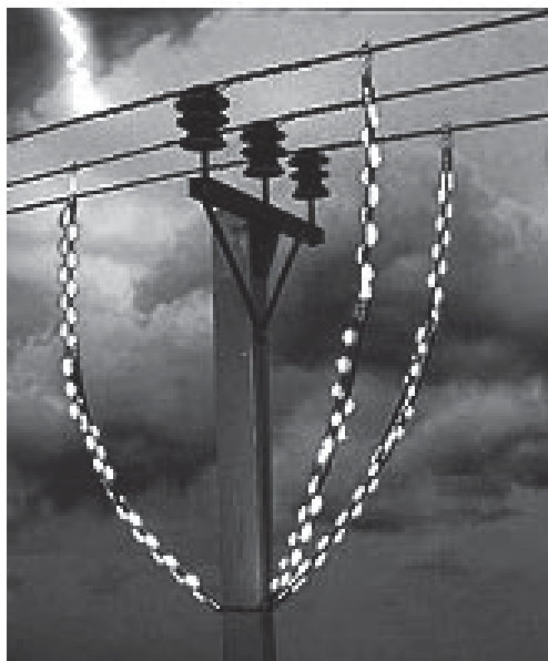
Рис. 4.7. Момент срабатывания усовершенствованного разрядника РДИМ
