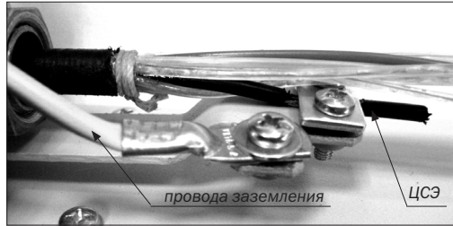
Рисунок 4.11 – Крепление на кронштейне ЦСЭ (металлический трос с полимерным покрытием) кабеля и провода заземления
