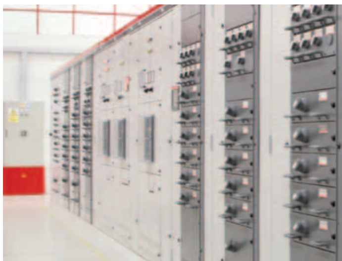
Рис. 2 — НКУ первичного распределения электроэнергии
