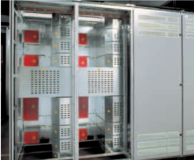
Рис. 8 — Каркас НКУ, с разделением 4b, вид со снятыми задними дверями. На металлических ограждениях сборных и распределительных шин можно закрепить предупредительные знаки. Тоже самое относится и к крышкам, закрывающим пространство для присоединения кабелей.
