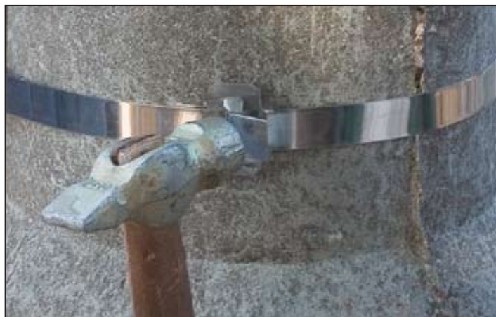
Рисунок 5.2 - Подбивание ленты и зажимов замка для хомутов
