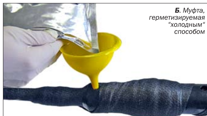
Рисунок 3.14 – Заливка герметика в муфты
