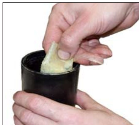
Рисунок 3.1 – Смазка внутренних поверхностей гидрофобным наполнителем кабеля
