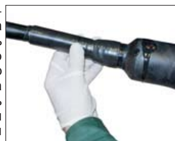
Рисунок 3.15 – Выпуск воздуха из корпуса муфты
