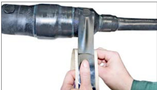
Рисунок 3.17 – Наложение ленты VM поверх пробок
