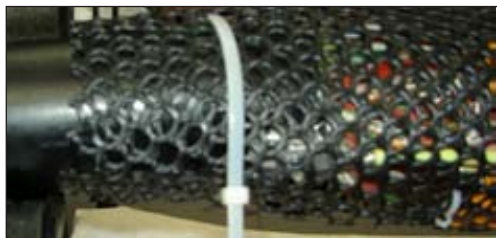
Рисунок 3.6 – Скрепленная на сrostке сетка
