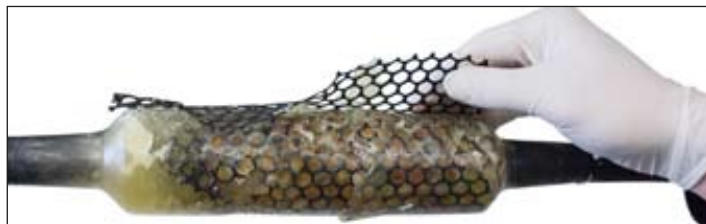
Рисунок 4.2 – Снятие сетки со сростка
