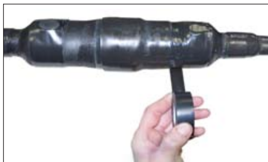
Рисунок 3.18 – Наложение ленты 88T поверх ленты VM
