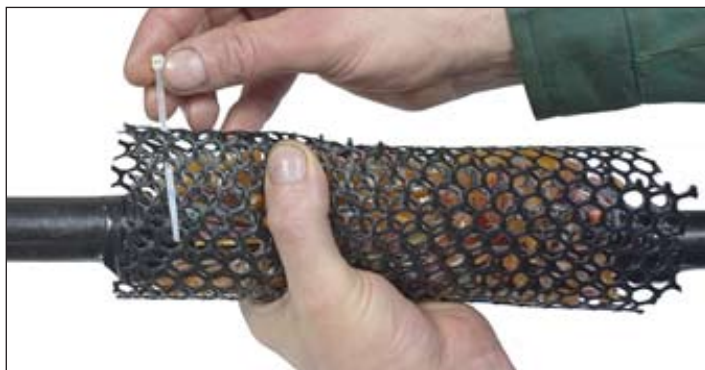
Рисунок 3.5 – Установка сетки на сrostок и крепление стяжками
