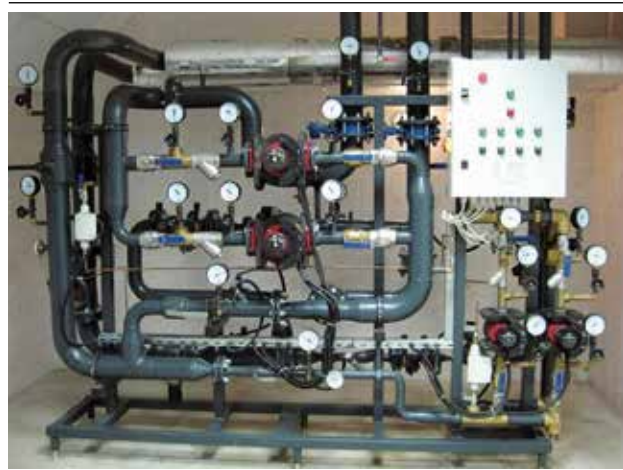
Рис. 2. Пример теплового пункта блочного исполнения с оборудованием, приборами и устройствами Danfoss.
